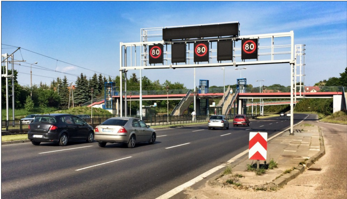
Rys. 26. System Znaków zmiennej treści VMS firmy APM z dnia 01.07.2019 r.
